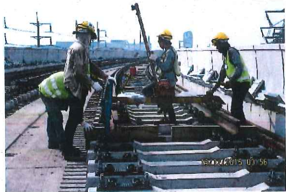
รูปที่ 1-15 งานติดตั้งรางรถไฟฟ้าบริเวณทางวิ่ง
