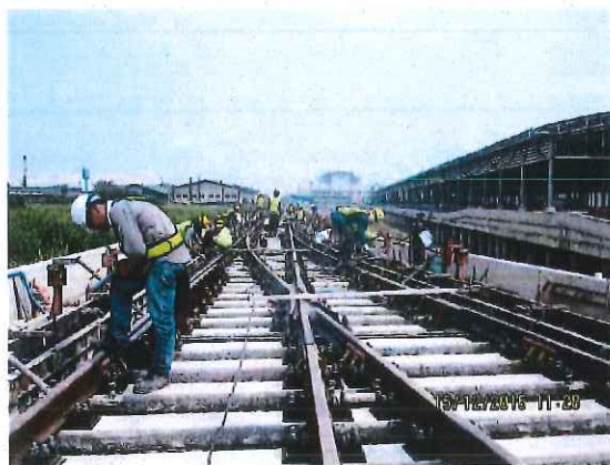
รูปที่ 1-16 งานติดตั้งรางรถไฟไฟฟ้าที่ศูนย์ซ่อมบำรุง
