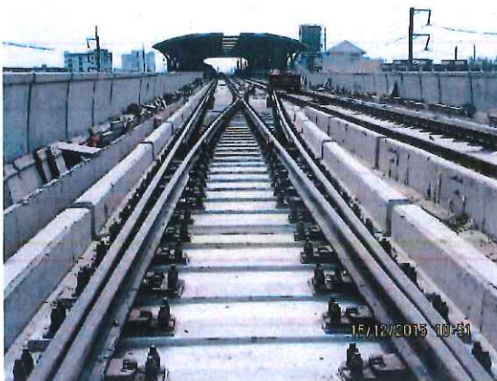
รูปที่ 1-15 งานติดตั้งรางรถไฟฟ้าบริเวณทางวิ่ง
